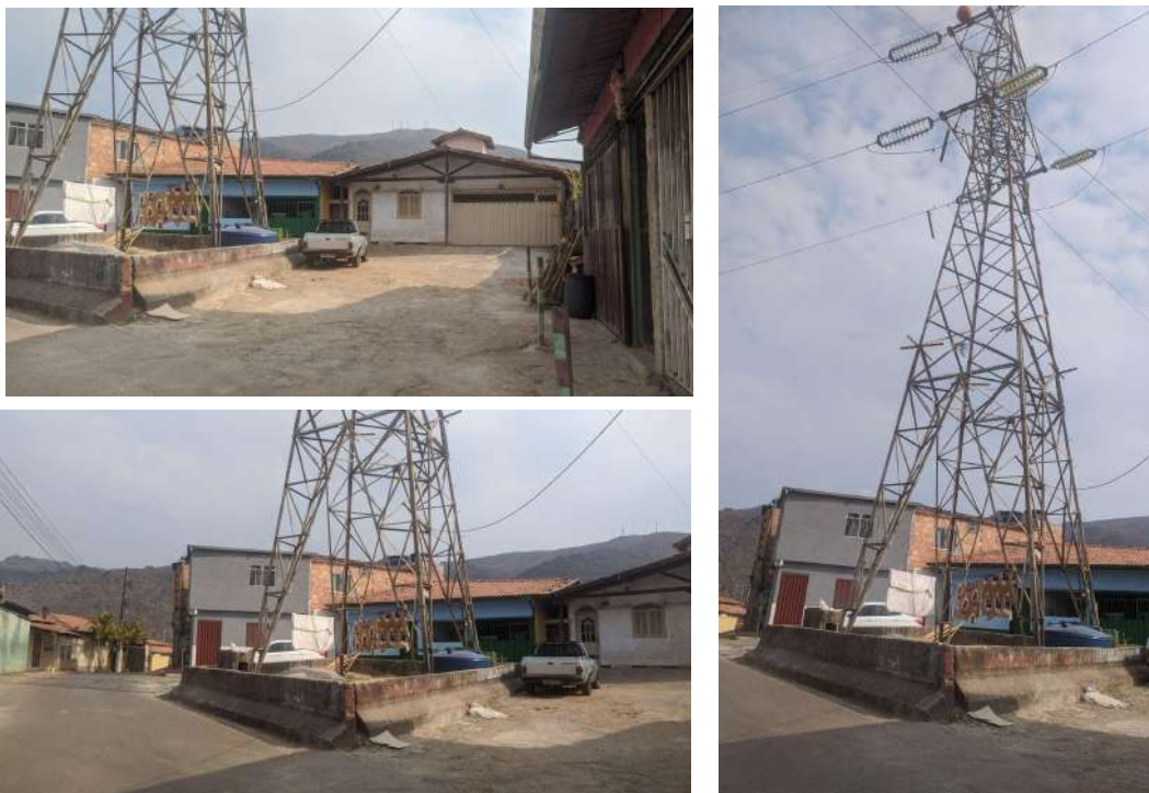
Imagem 22. Residências próximo a torre de transmissão de energia, 2022
