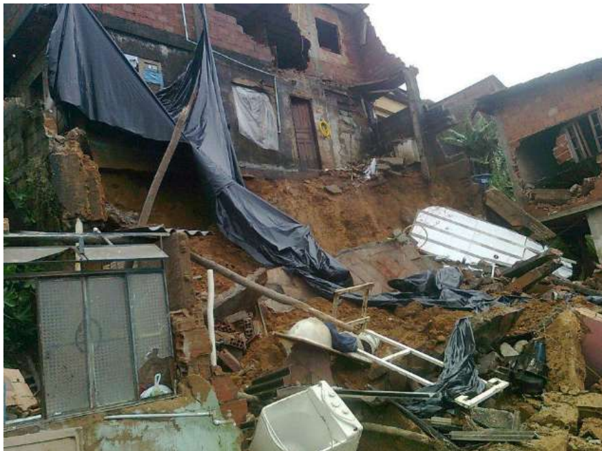
Imagem 15. Desabamento de residência no bairro Padre Faria, em virtude de instabilização no terreno.
