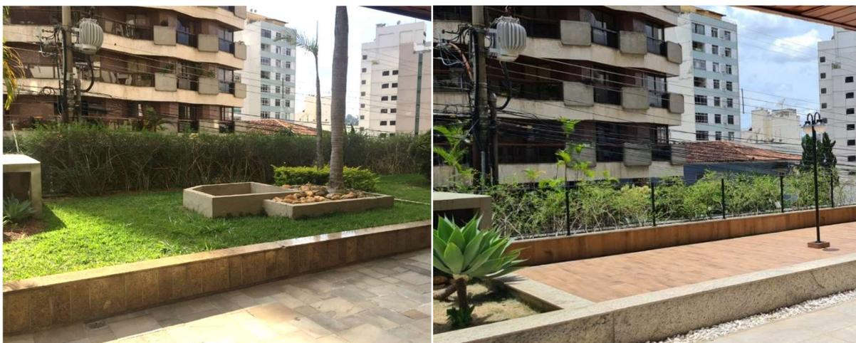
**Figura 7 - Jardim superior a garagem da edificação, antes (esquerda) e depois (direita) da reforma de remoção do jardim e impermeabilização da laje. (Fonte: autora)**
