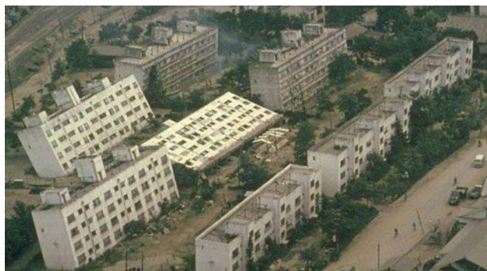
Figura 1 - Prédios inclinados em razão de liquefação induzida por sismo, após terremoto de 1964 em Niigata, Japão.
