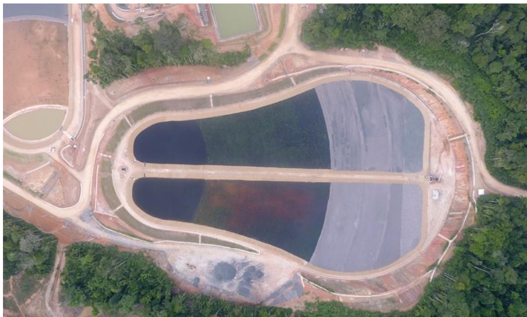
Figura 22: Wetland construída para tratar a água proveniente do bombeamento da mina subterrânea da empresa NEXA situada no complexo da cidade de Aripuanã-MT.
