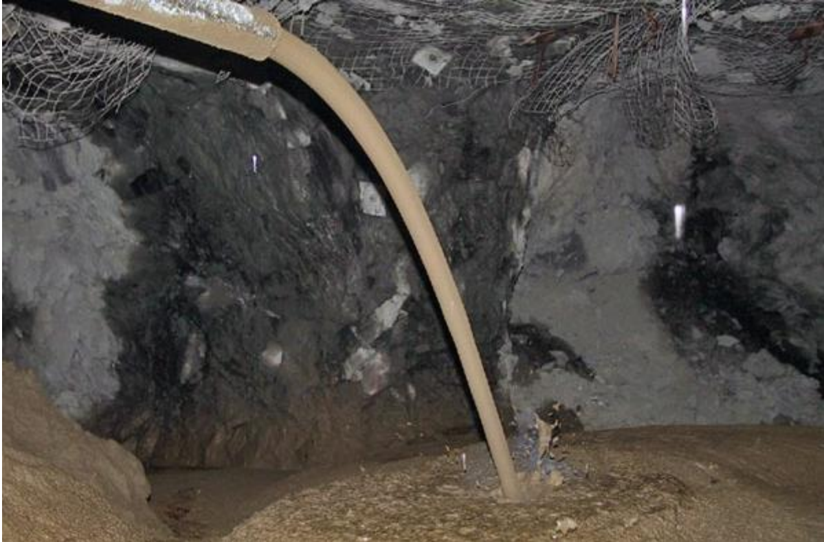
Figura 14: Enchimento de vazio gerado pela lavra de ouro na mina de Barrick Gold Corporation no Canadá.
