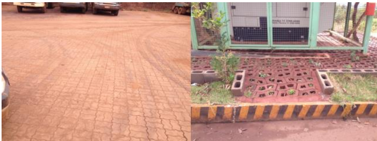
Figura 11: Blocos produzidos e utilizados no complexo BLOCOITA.
