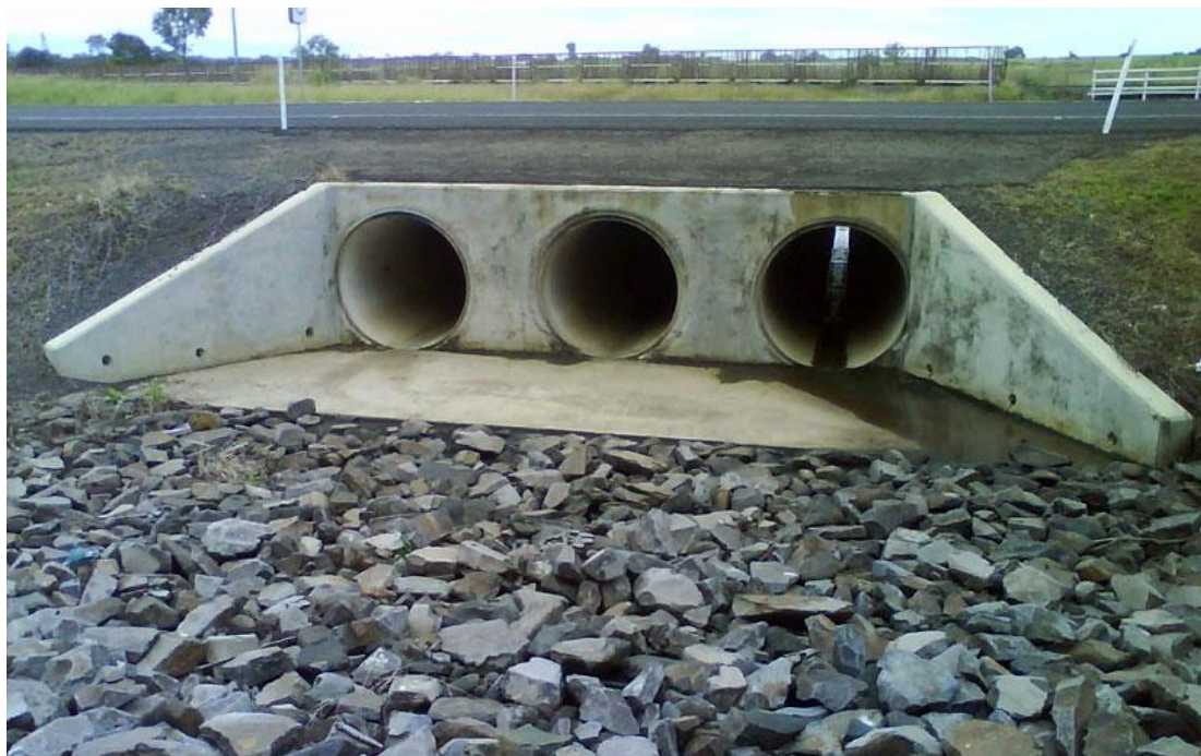
Figura 16: Rocha estéril utilizada na drenagem de águas de chuva.
