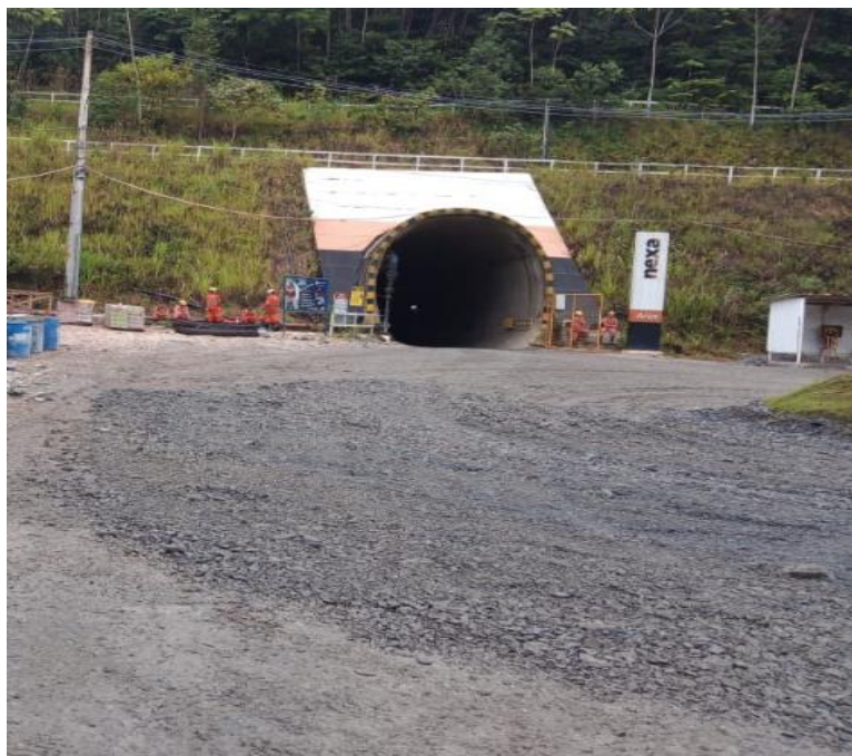
Figura 18: Rocha estéril utilizada como pavimento nas vias de acesso a mina da Nexa na cidade de Aripuanã – MT.
