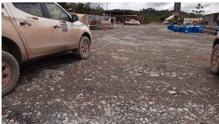
Figura 19: Pavimentação realizada com rocha estéril no Canteiro da Andrade Gutierrez na mina da Nexa no complexo Aripuanã - MT.
