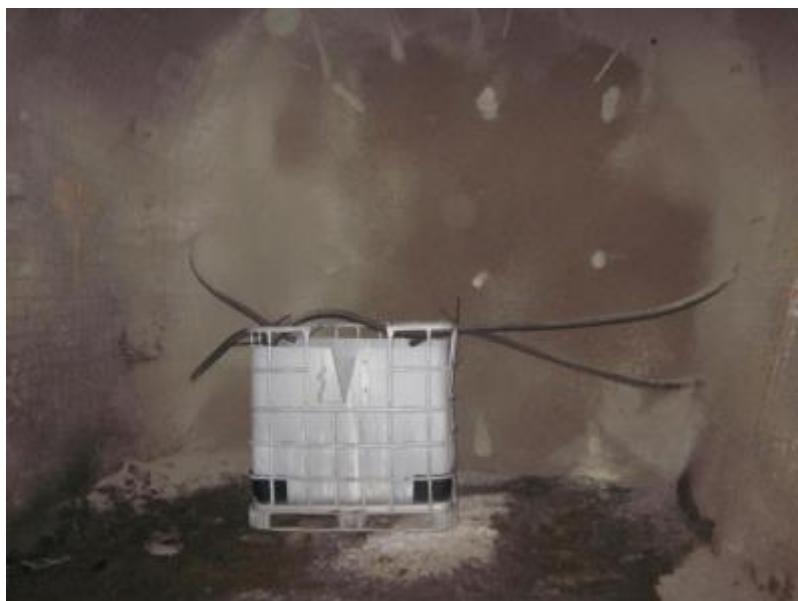
Figura 15: Muro de contenção/barricada com drenagem em teste na Mina Raleigh.
