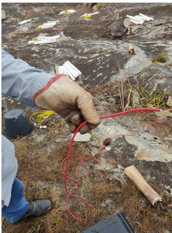
Figura 13 - Cordel detonante
