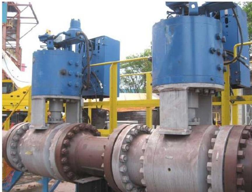
Figura 7: Válvulas de bloqueio.
