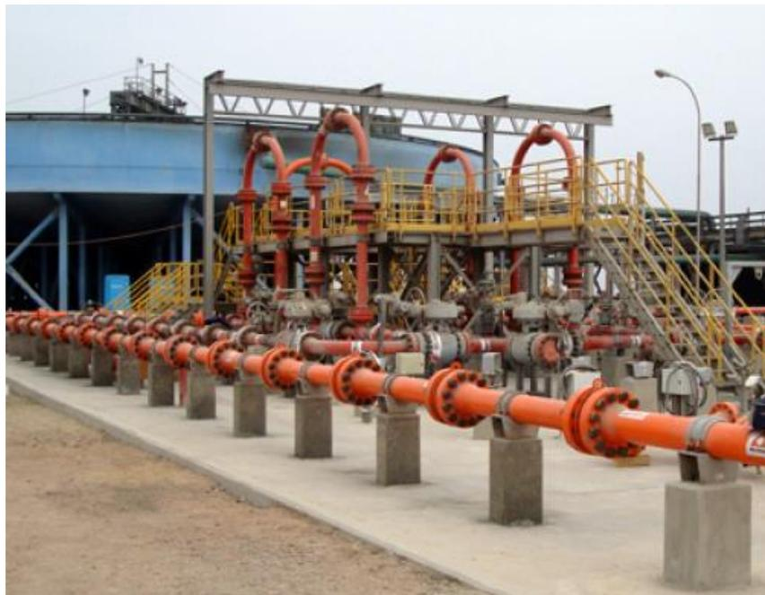
Figura 3: Estação de Válvulas e Orifícios.
