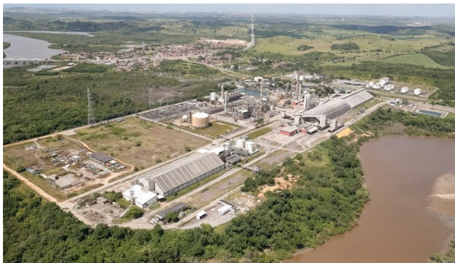
Figura 19: Usina Termoelétrica Porto de Sergipe. Fonte: Brasil (2020).
