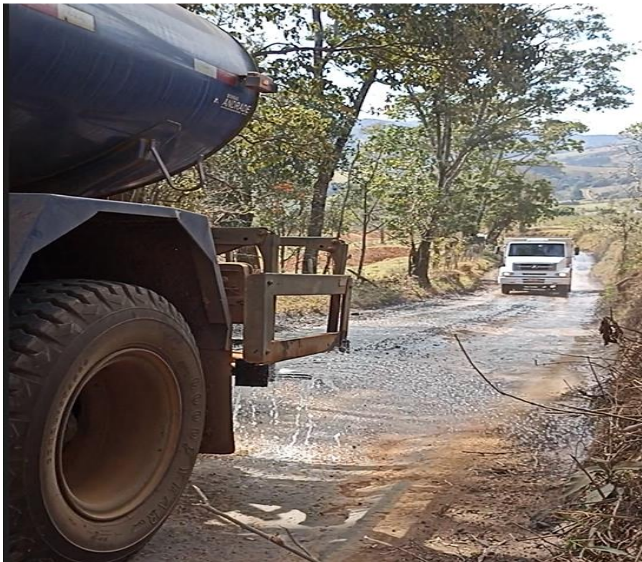
Figura 7 - Caminhão pipa umectando o piso com água.
