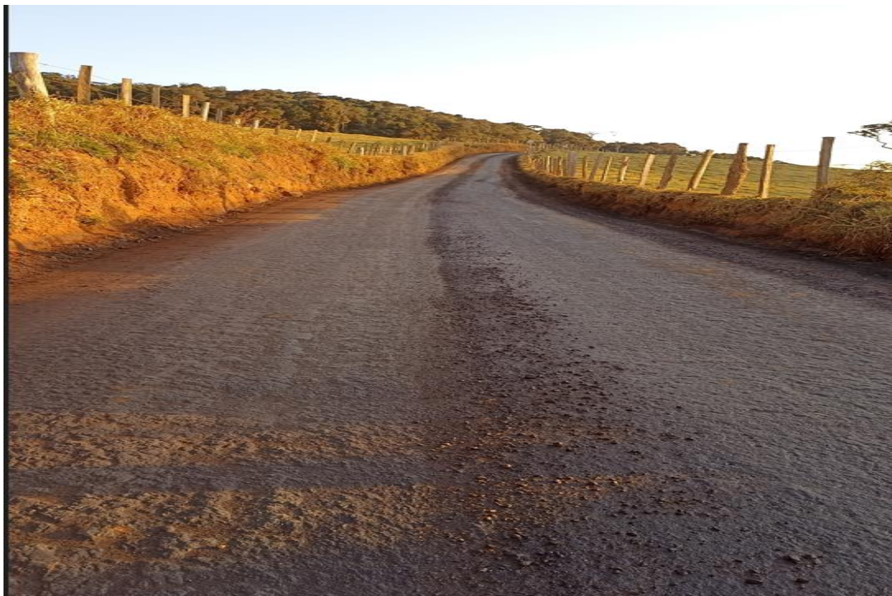
Figura 5 - Camada base formada.
