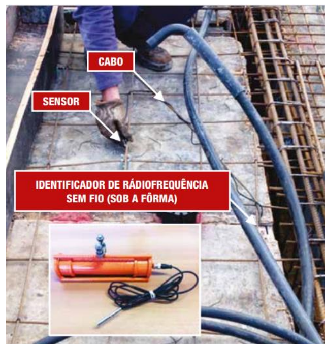
Figura 2.11 - Instalação dos sensores de temperatura junto à armadura da laje.
