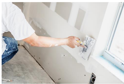
Figura 10 – Aplicação da massa de gesso nas juntas das placas. Fonte: iStock (2012).
