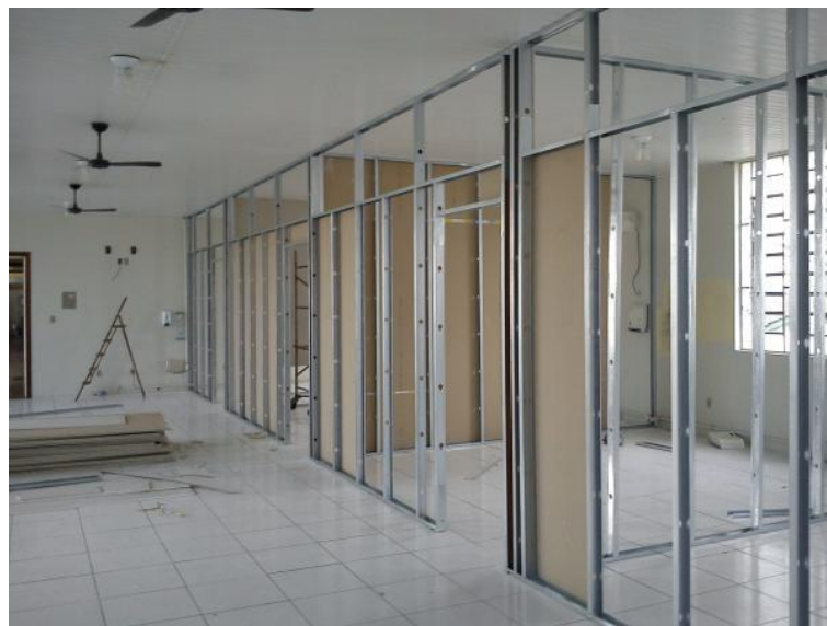
Figura 1 – Montagem de uma parede em drywall . Fonte: Sulmodulos (2022).
