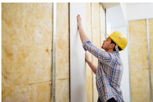
Figura 9 – Instalação da placa de gesso sobre a lã de vidro como isolante termoacústico. Fonte: iStock (2016).
