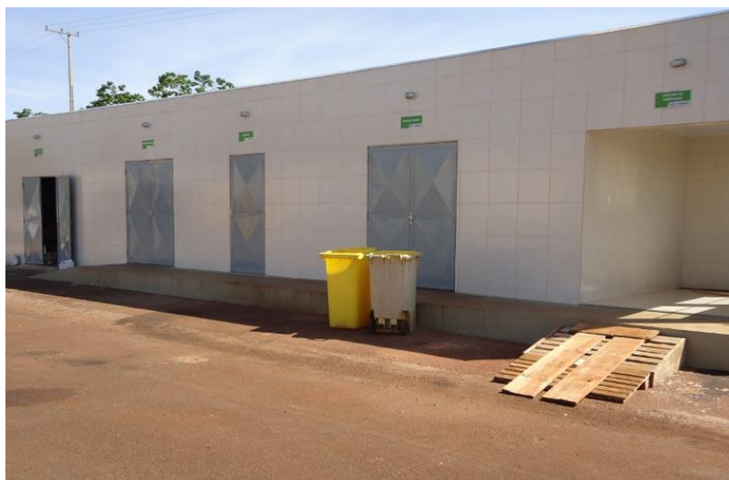
Figura 10 – Portas de abrigo de resíduos
