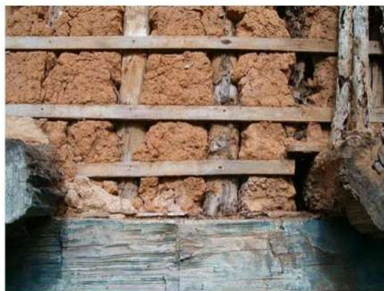
Figura 28: Trama criada com paus roliços Figura 29: Trama criada com paus roliços e serrados
