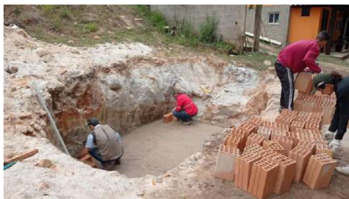
Figura 35: Etapa da construção das paredes.
