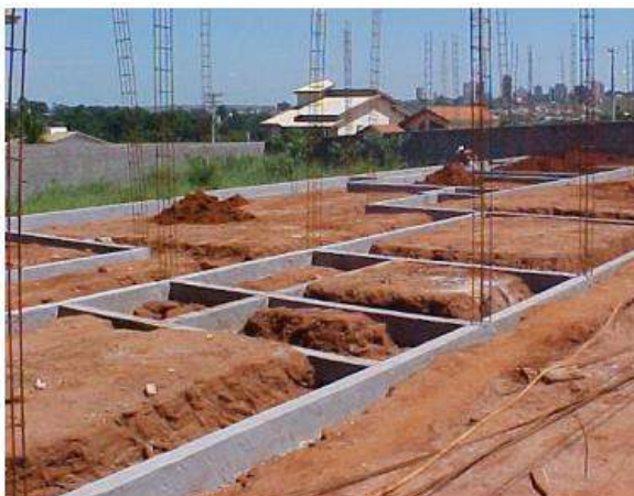
Figura 33: Vigas baldrame para poio das paredes.
