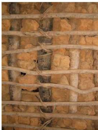
Figura 28: Trama criada com paus roliços Figura 29: Trama criada com paus roliços e serrados
