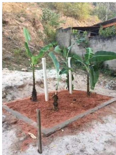
Figura 34: Bacia de evapotranspiração construída em Cachoeira do Brumado.
