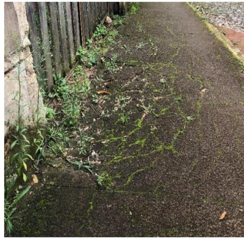
Figura 25 – Trecho com fissuras no segmento 20.
