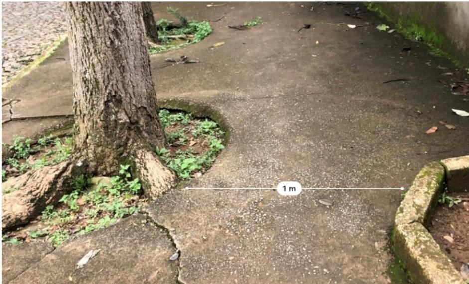
Figura 23 – Trecho do segmento 20 com largura efetiva inferior à 1,40m.
