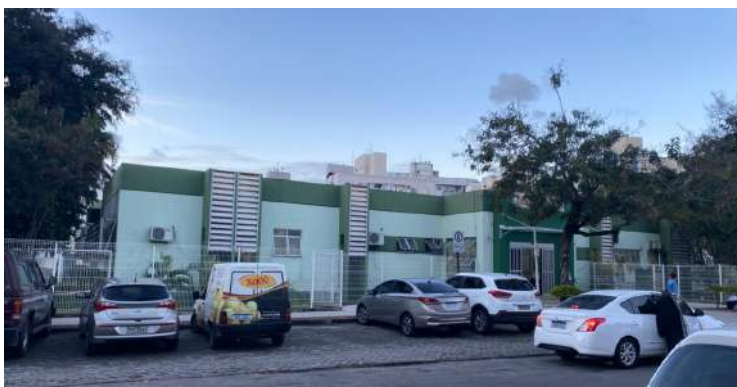
Figura 18: Fachada UBS Jardim Camburi.
