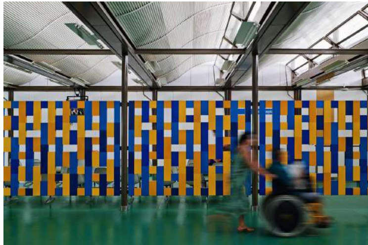
Figura 7: Uso de Shed na Rede Sarah - Lelé.
