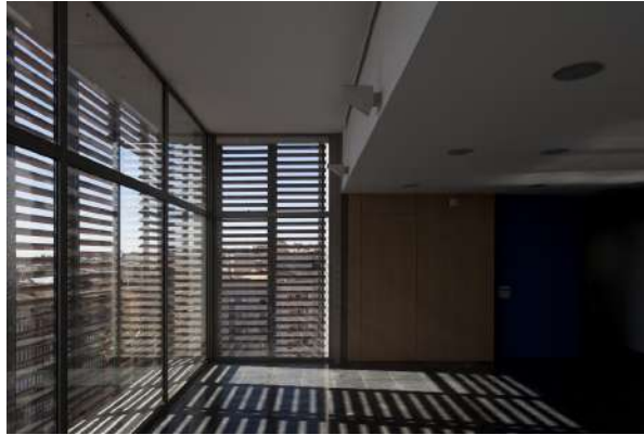
Figura 2: Brise fixo horizontal.
