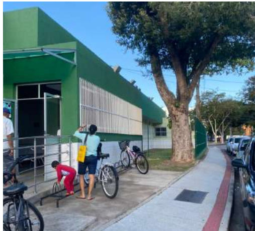
Figura 35: Fachada da UBS Jabour.
