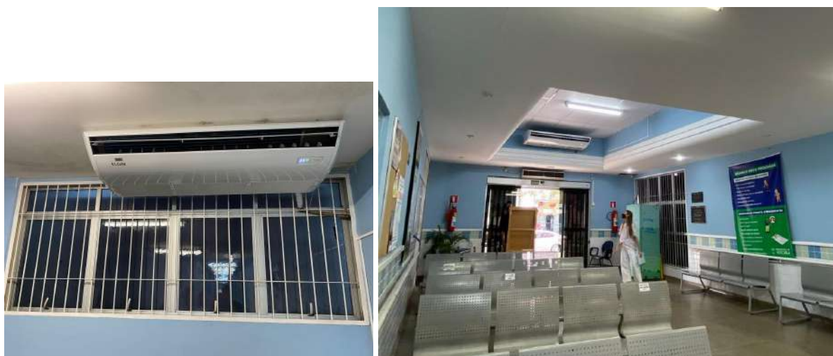
Figura 23: Intervenções nas esquadrias da UBS Jardim Camburi.
