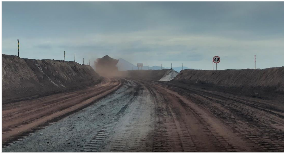
Figura 9. Poeira fugitiva devido a movimentação do caminhão basculante
