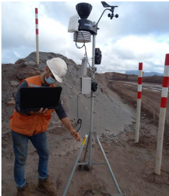
Figura 22. Estação de monitoramento de poeira instalada na mina da Anglo American
