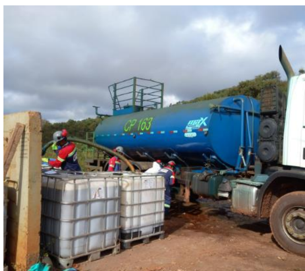
Figura 15. Caminhão pipa sendo abastecido com o ea1
