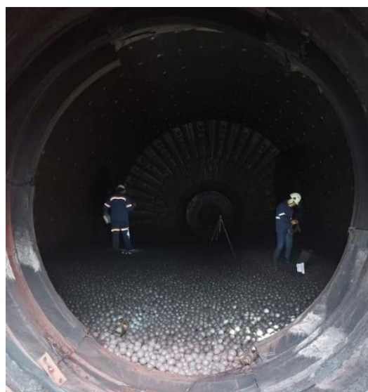
Figura 1.5: Foto do interior do moinho de bolas MB02 durante inspeção de revestimento (AUTOR, 2022).
