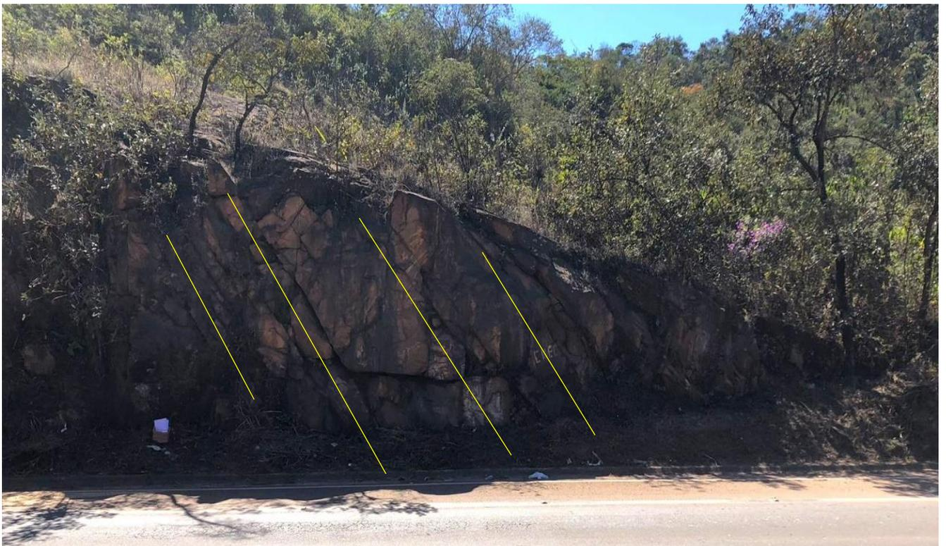
Figura 15 - Descontinuidades em evidência no talude em estudo.
