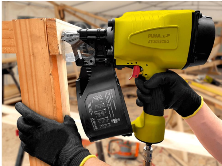
Figura 24 – Ilustração representativa da pistola de pregos pneumática sendo utilizada para a fixação entre estruturas de madeira. Fonte: Puma Brasil, 2021.
