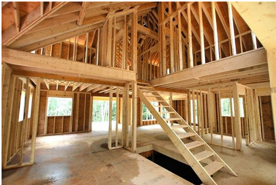
Figura 13 – Execução de obra em Wood frame – lado interno. Fonte: Pereira, 2019.
