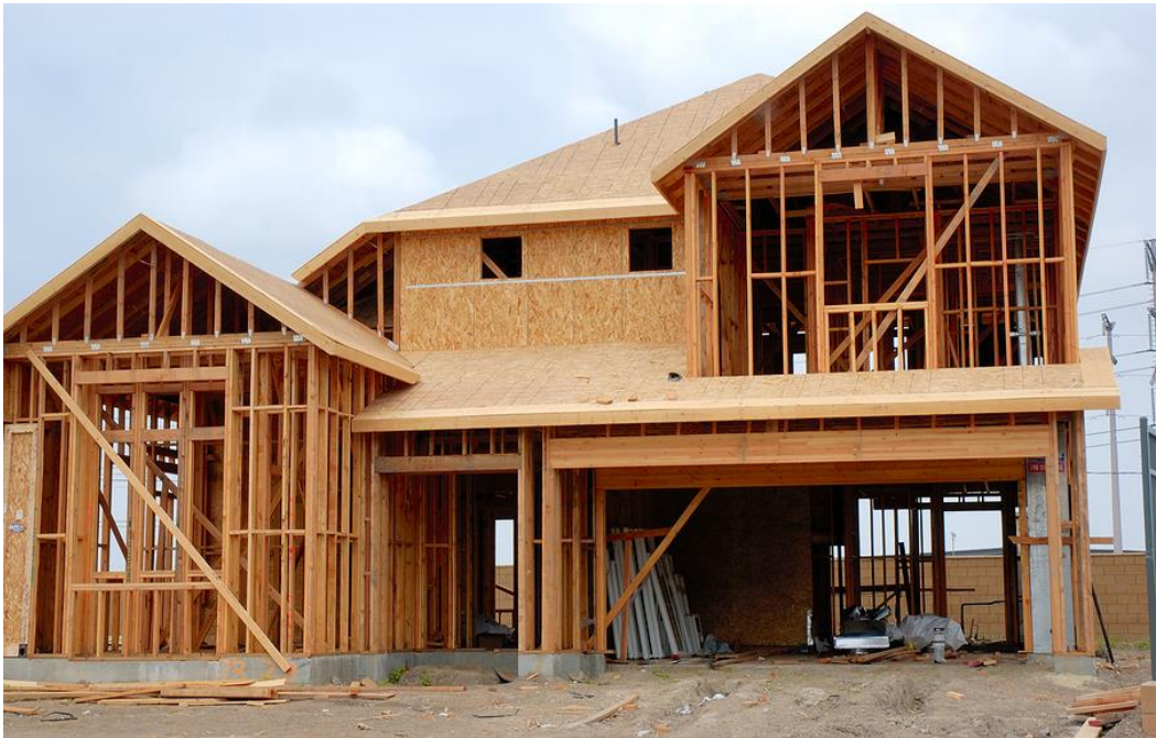
Figura 12 – Execução de obra em Wood frame – lado externo. Fonte: Blog Salles, 2019.
