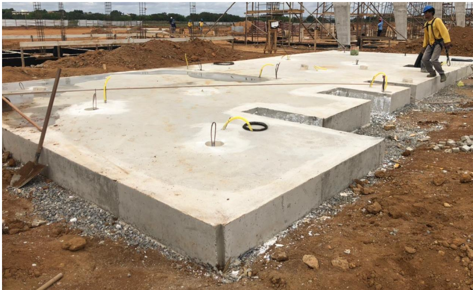
Figura 15 - Radier executado e com as infraestruturas elétricas e hidráulicas já posicionadas, na obra de reforma e ampliação do Aeroporto Coronel Altino Machado de Oliveira na cidade de Governador Valadares - MG. Fonte: Autor, 2022.
