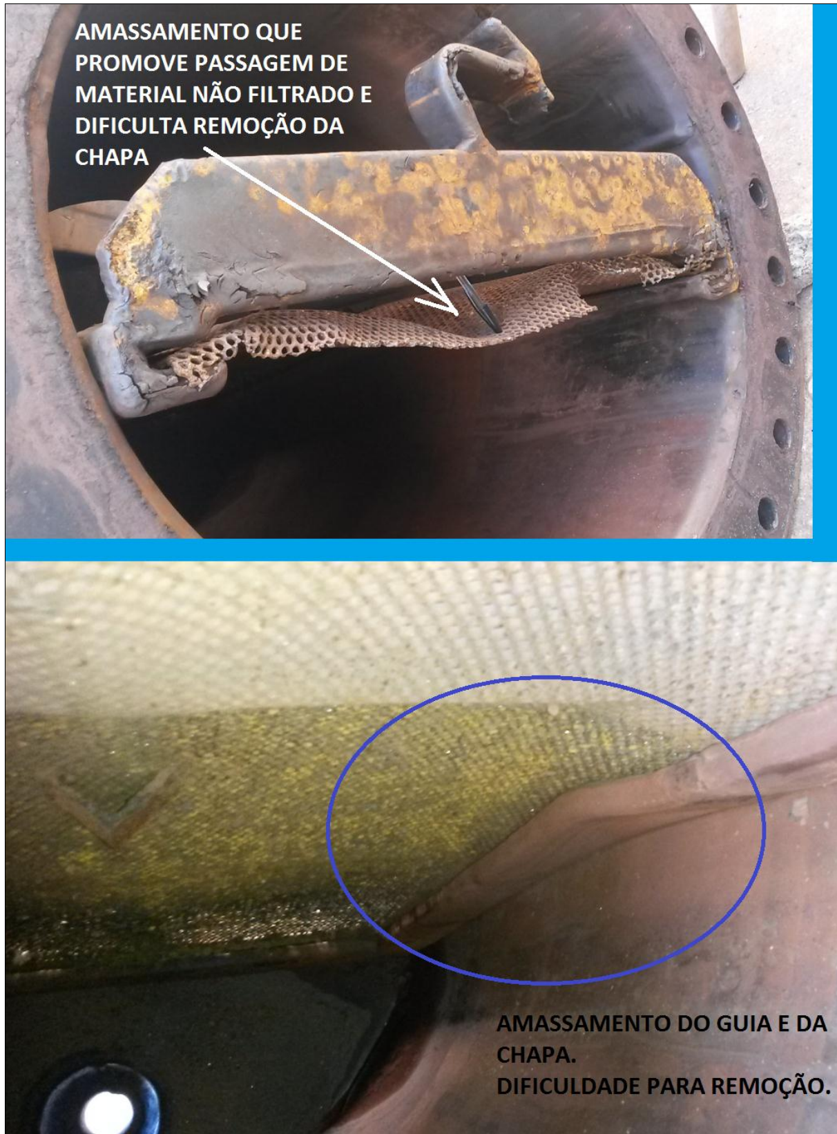
Figura 18 – Amassamento na chapa perfurada que eleva o tempo de manutenção de troca Fonte: Pesquisa direta (2017)
