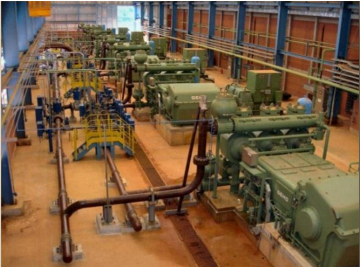
Figura 9 - Estação de bombeamento de polpa mineral com bombas hidrostáticas Fonte: Pesquisa direta (2017)
