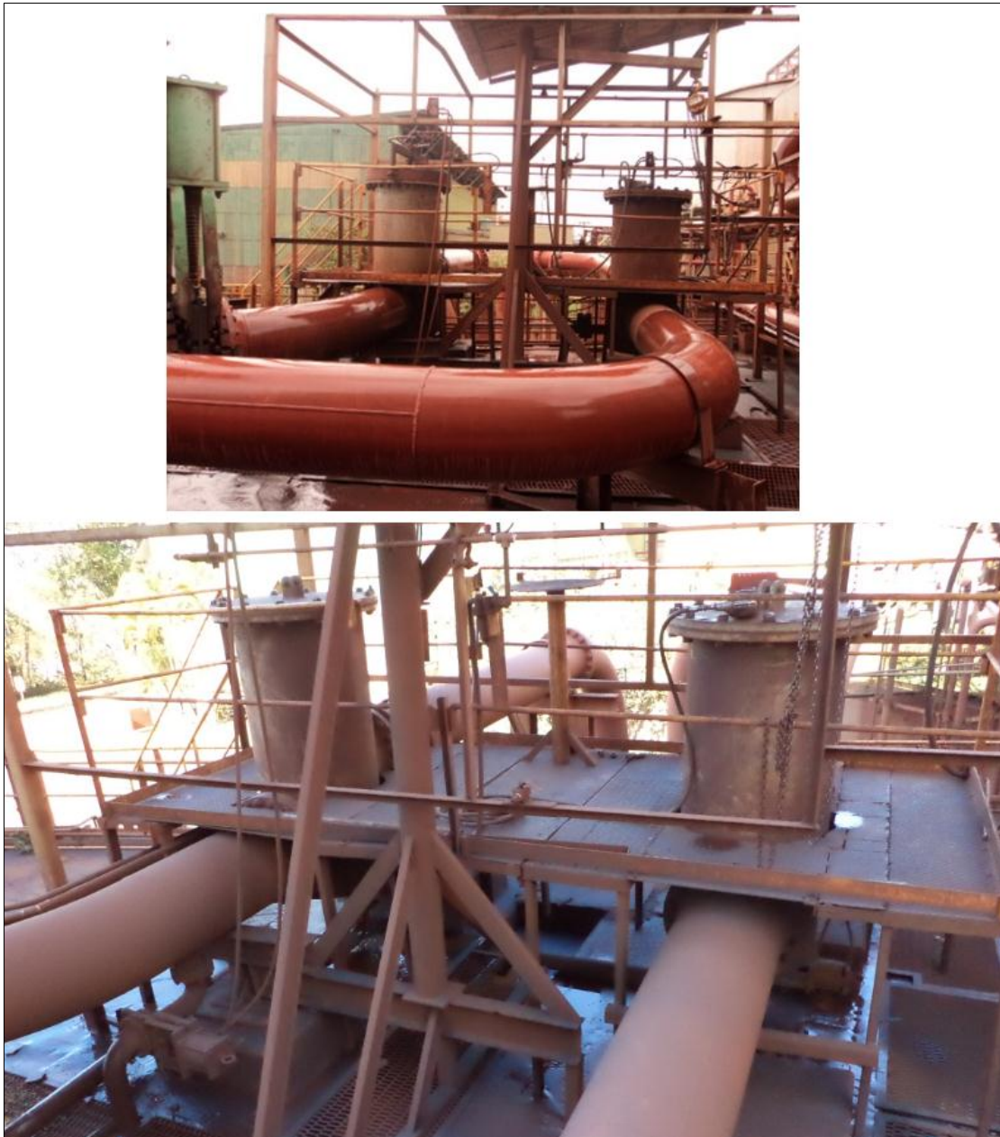
Figura 27 – Imagem do local onde estão instalados os componentes de filtração Fonte: Pesquisa direta (2017)
