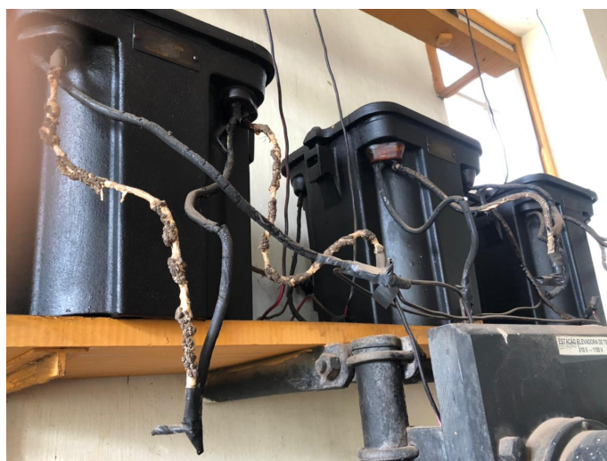
Figura 19 – Transformadores com fiação antiga.
