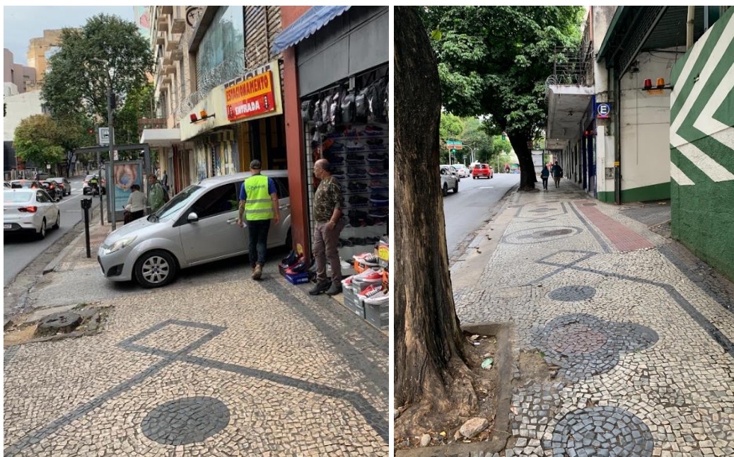
Figura 5-10 – Estacionamento de carros e ponto de ônibus obstruindo a calçada – Trecho 3A.
