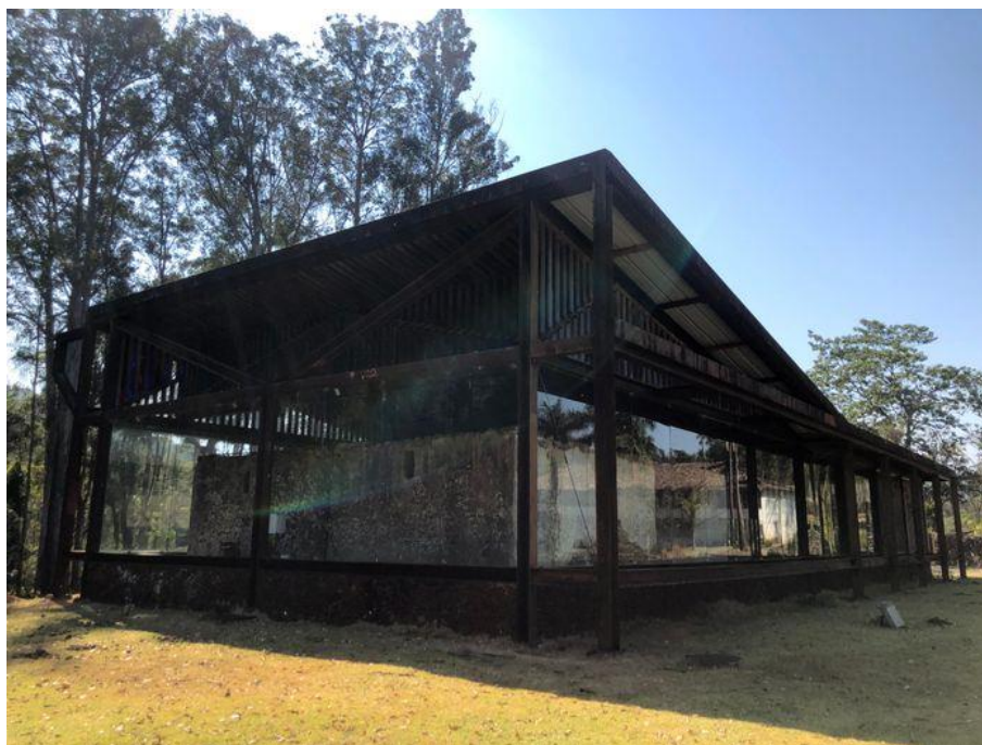
Figura 15 - Vista externa da construção
