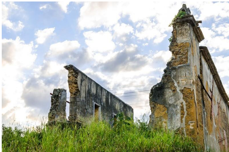
Figura 9 - Amarrações das paredes da ruína da Igreja de São José do Queimado.
