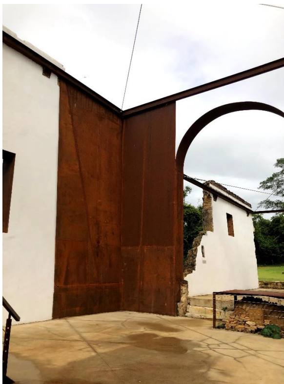
Figura 11 - Reconstrução em aço de parte da parede da Igreja de São José do Queimado
