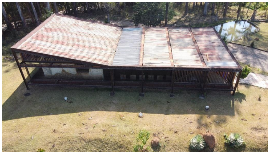
Figura 16 – Inclinação do telhado.
