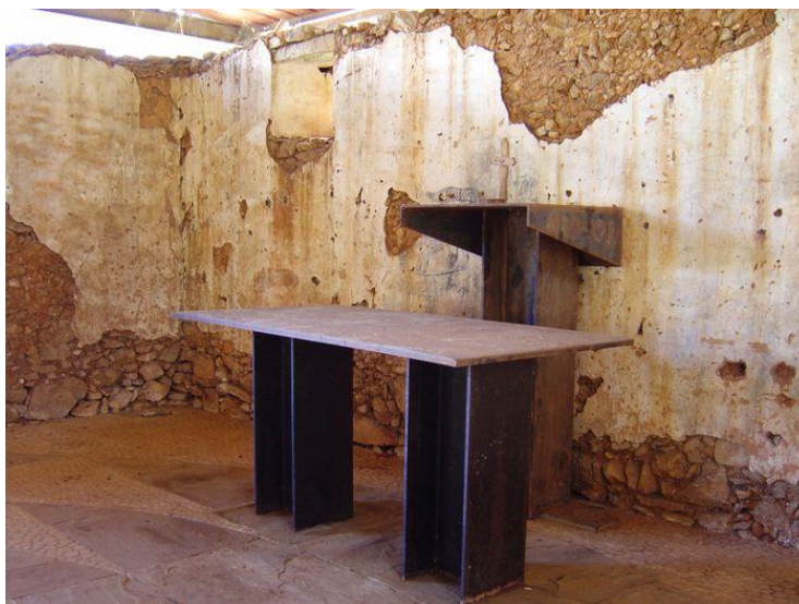
Figura 12 - Paredes em ruínas que fazem parte do altar-mor
