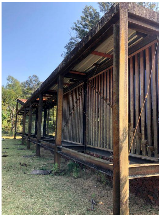
Figura 16 - Avanço lateral da cobertura
