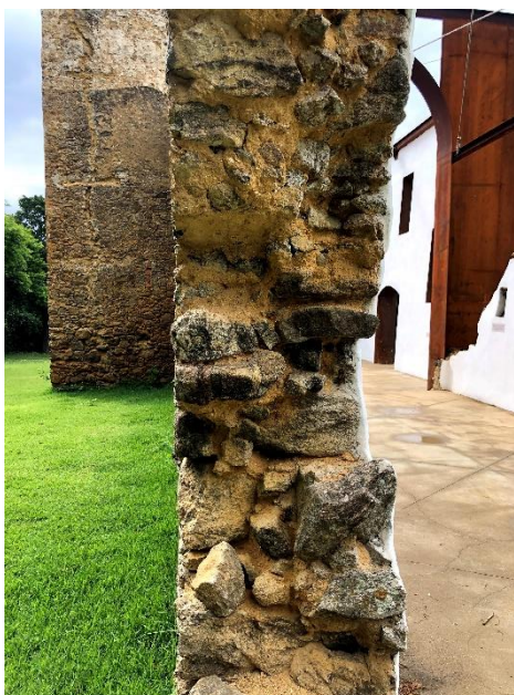
Figura 7 - Detalhe da técnica construtiva da Igreja
