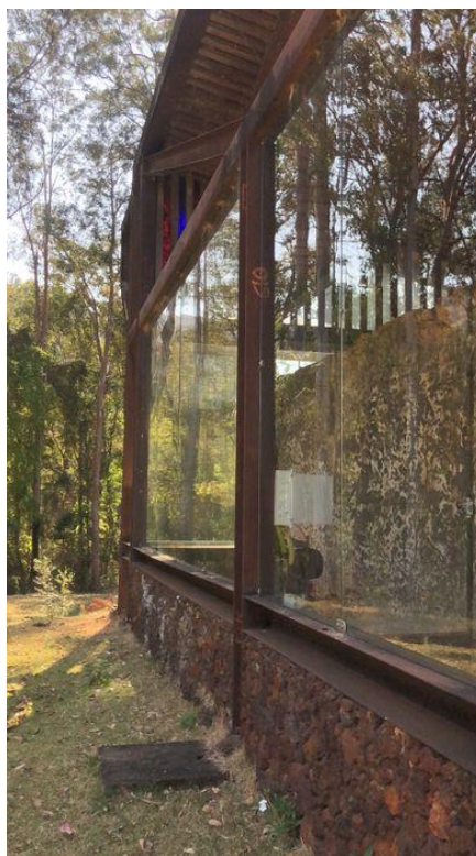
Figura 17 - Detalhe da base em pedra, vidro e estrutura metálica
