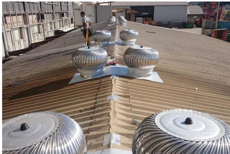
Figura 9 - Instalação de exaustores eólicos
