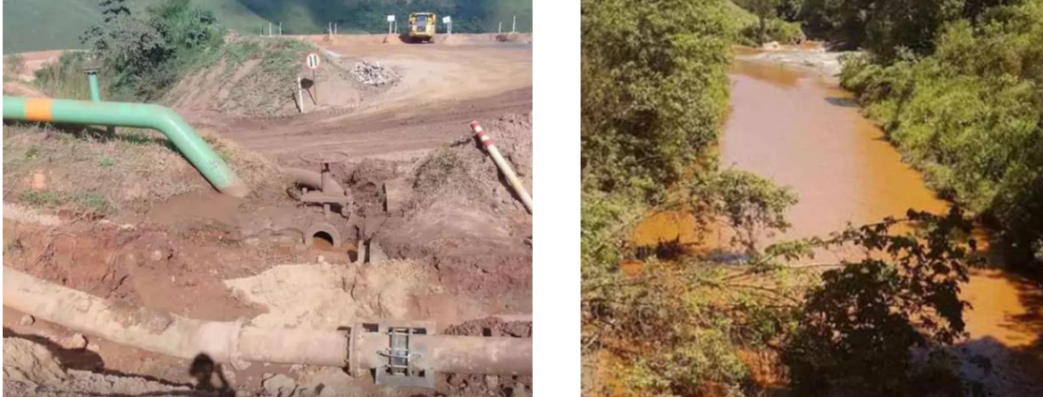
Figura 3: (a) imagem à esquerda: tubulação do rejeitoduto rompida; (b) imagem à direita: Rio atingido pelos rejeitos provenientes do rompimento do Rejeitoduto Fonte: Jornal Estado de Minas. (2017).
