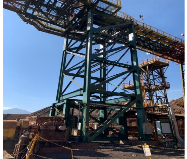
Figura 30 - Estrutura da correia após manutenção. Fonte: Pesquisa direta (2022).
