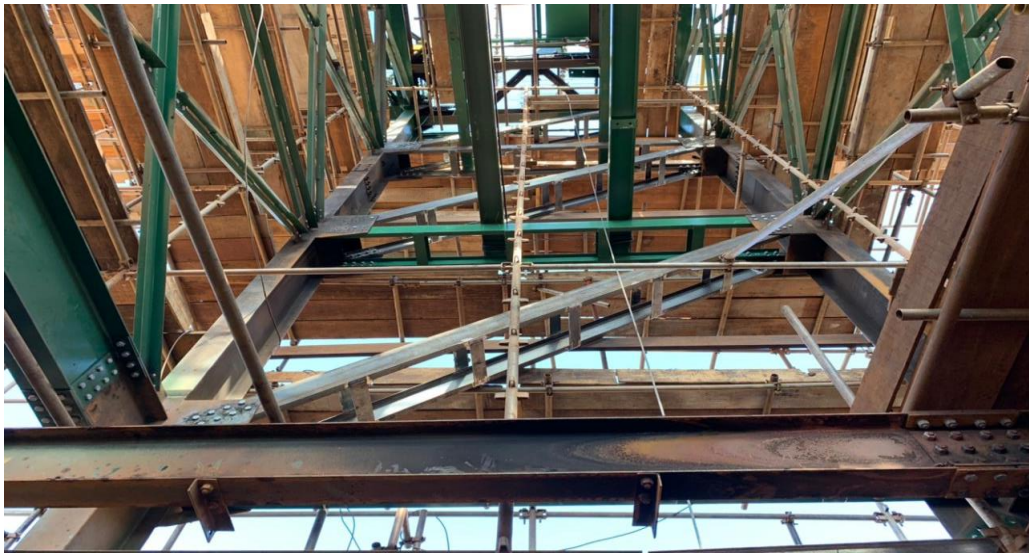
Figura 22 - Substituição de vigas danificadas. Fonte: Pesquisa direta (2022)
