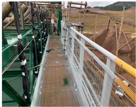
Figura 24 - Tratamento Anticorrosivo nas estruturas. Fonte: Pesquisa direta (2022)
