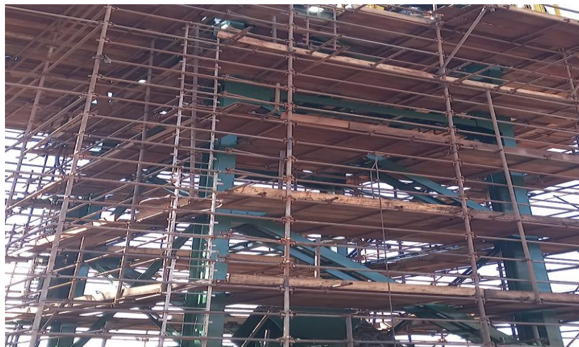
Figura 27 - Tratamento anticorrosivo em vigas substituídas. Fonte: Pesquisa direta (2022)
