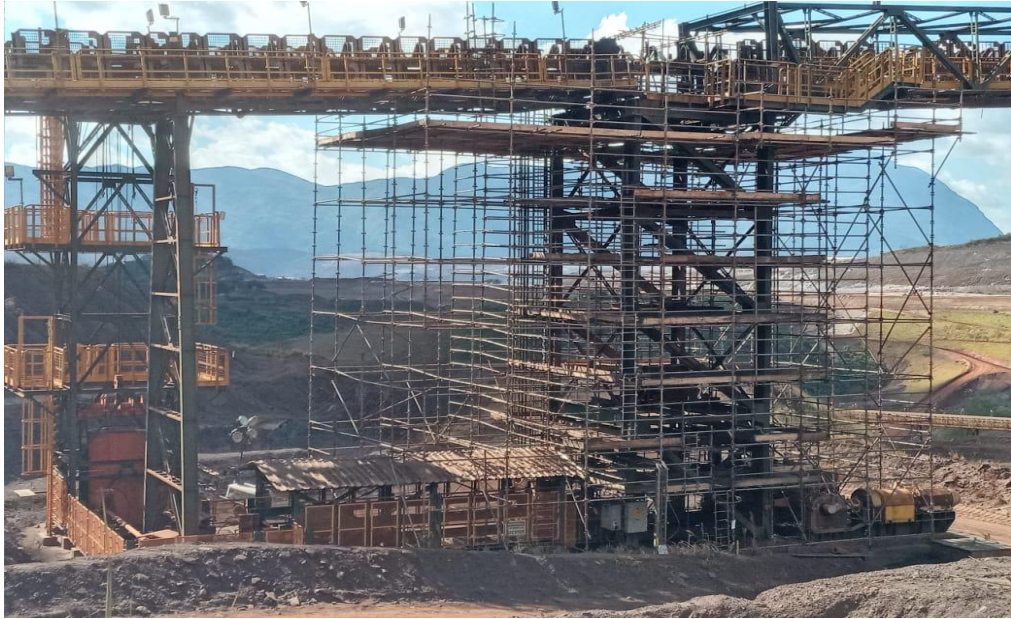
Figura 17 - Montagem e liberação do andaime estrutural. Fonte: Pesquisa direta (2022).
