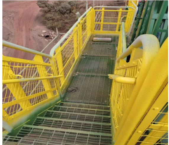
Figura 26 - Aplicação de tinta, no revestimento. Fonte: Pesquisa direta (2022).
