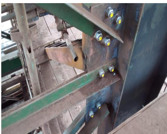
Figura 20 - Substituição de parafusos danificados. Fonte: Pesquisa direta (2022).
