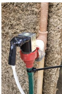
Figura 10 – Válvula solenoide de 220V
