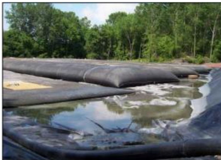
Figura 1 – Estrutura do sistema de tubos geotêxteis.
