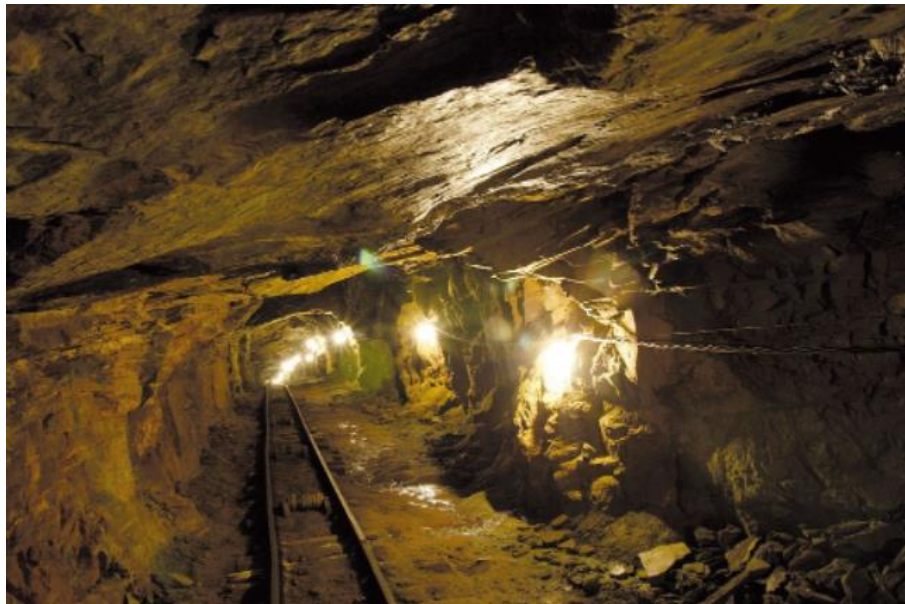
Figura 1.1 – Galeria de transporte na mina de Passagem, em Mariana (MG).
