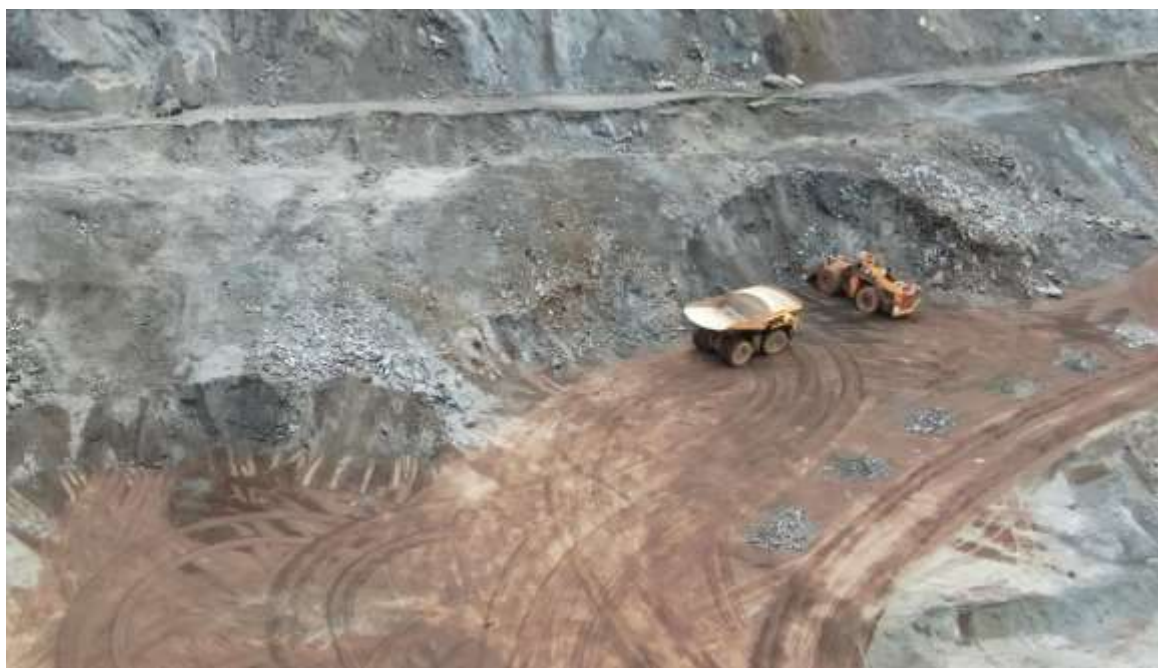
Figura 11 - Imagem após desmonte da área 7K - teste final 2
