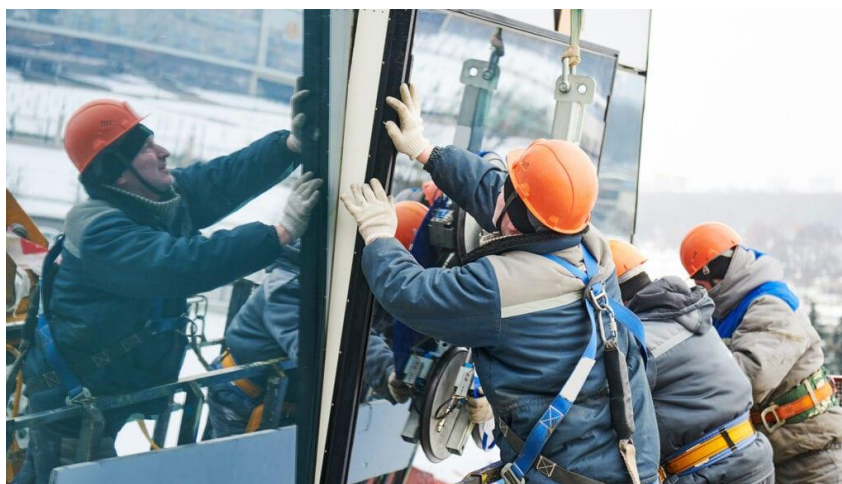
Figura 8 – Instalação de uma folha no sistema de fachada Stick . As folhas são instaladas uma a uma pelo lado externo (PKO, 2021).
