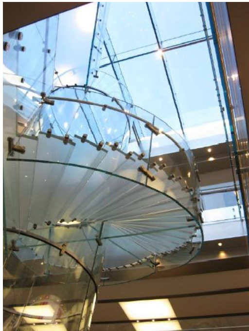
Figura 19 – Escada e guarda corpo executados com vidro laminado, projeto: Apple Store em Nova Iorque (WESTPHAL, 2016).
