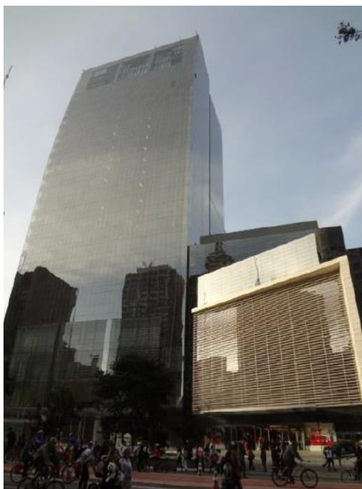
Figura 14 – Fachada da Torre de Matarazzo, em São Paulo, executada com vidros de controle solar e projetada por Aflalo e Gasperini Arquitetos (WESTPHAL, 2016).
