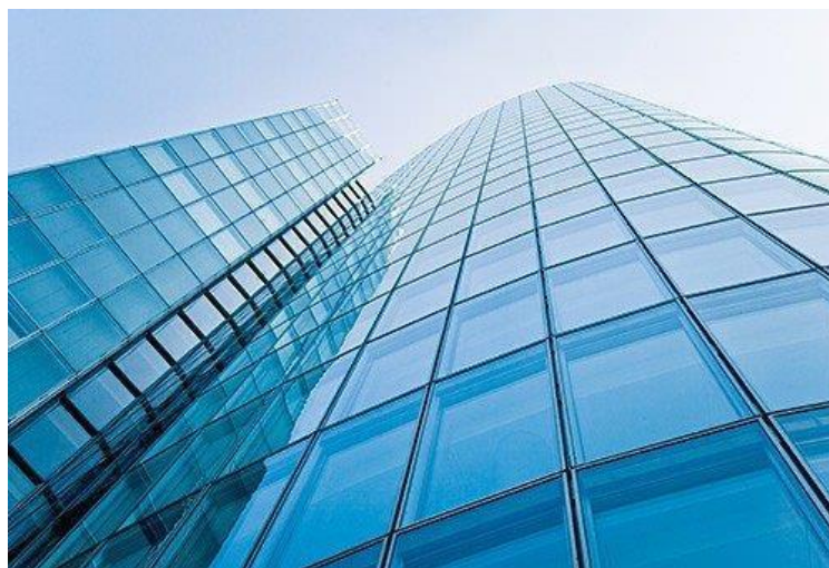
Figura 7 – Exterior de um edifício com fachada construída no sistema Stick (Fachada Stick , 2021).
