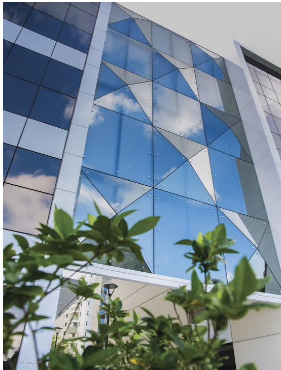
Figura 5 – Fachada da obra Blue Mall no Rio de Janeiro que ousou combinar Fachada Spider com vidros triangulares temperados-laminados e refletivos (PKO, 2018) .
