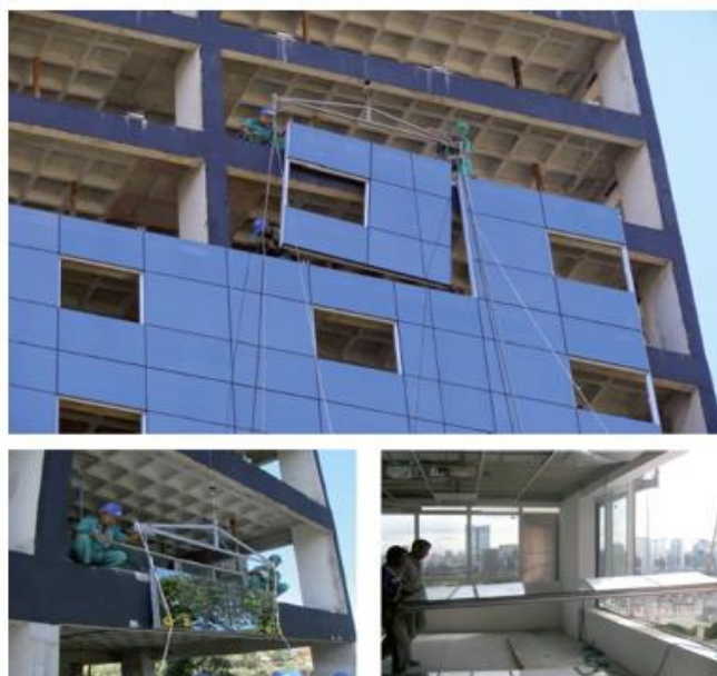
Figura 13 – Processo de içamento de um painel unitizado para sua fixação na fachada do prédio (MARTINS, AROUCA e AROUCA, 2013).
