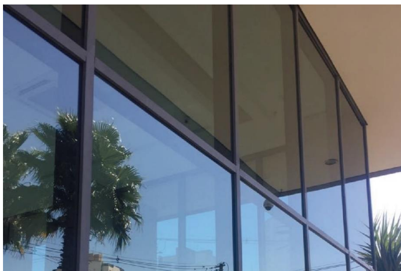
Figura 2 - Visual externo da fachada Grid (cortina) (Alquali, 2021).
