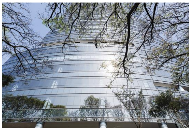
Figura 11 – Fachada de edifício construída com sistema unitizado (Abravidro, 2018).
