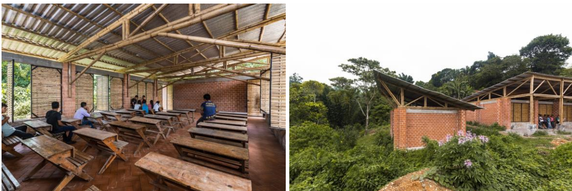
Figura 13 e 14: Interno das salas de aula - Estrutura e vedação.
