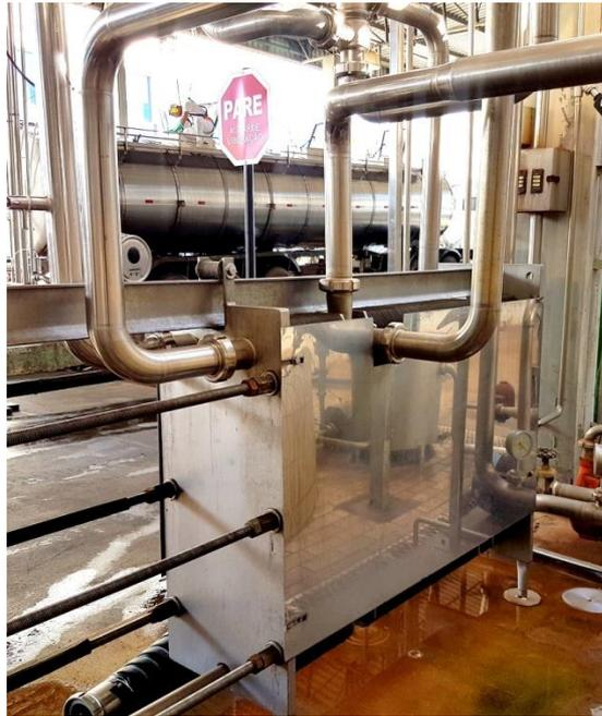
Figura 5.10: Pasteurizador APV SR26BS
