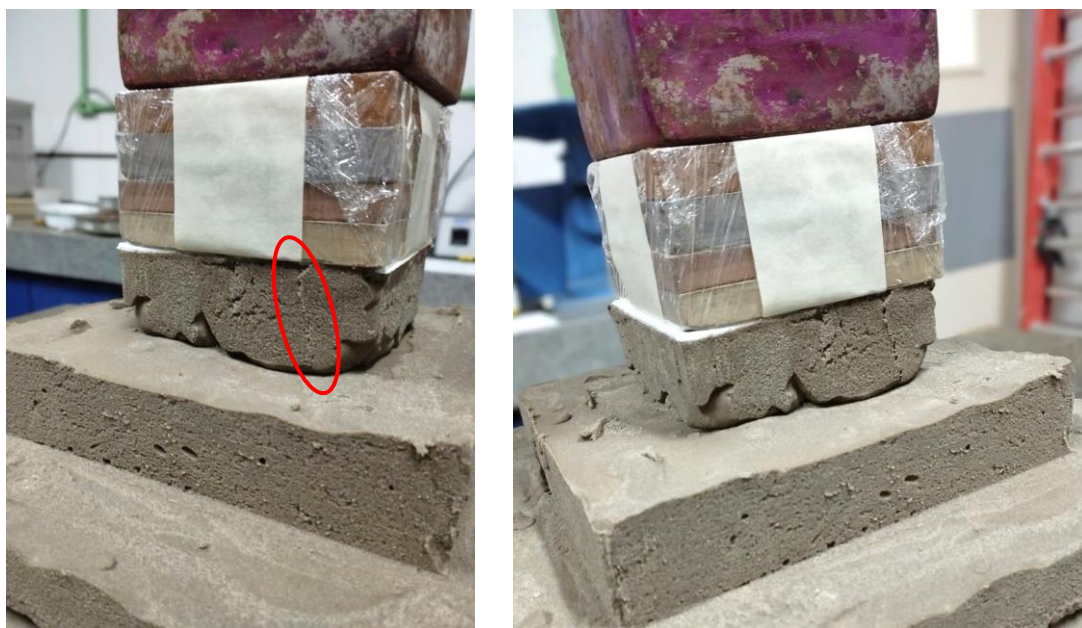
Figura 36 – Fissura da pilha RBMF-40-1-2 - 4ª Camada.
