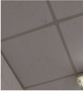
Figura 30 – Teto da Planta Piloto de Produtos Amiláceos com bolores
