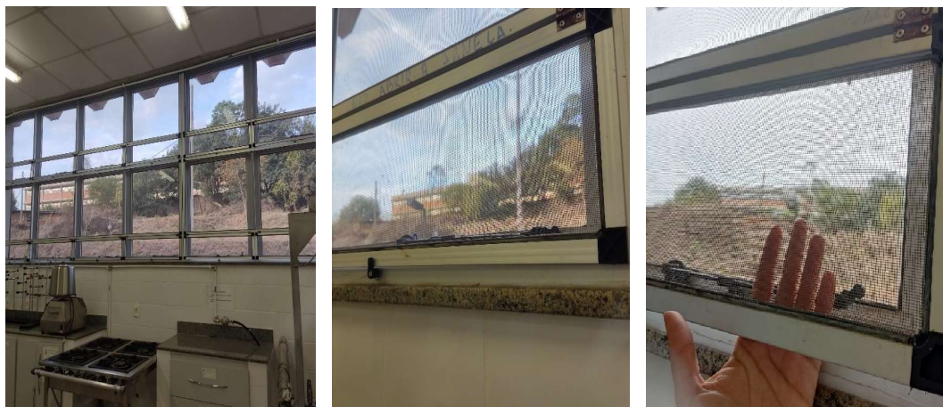
Figura 41 – Janelas e Telas de Proteção das Plantas Piloto
