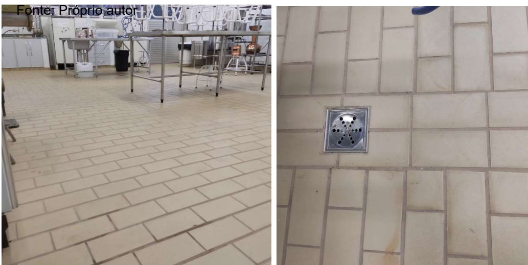
Figura 27 – Piso e Ralo da Planta Piloto de Produtos Vegetais e Bebidas
