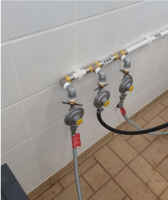
Figura 16 – Encanamento de gás nas plantas piloto.
