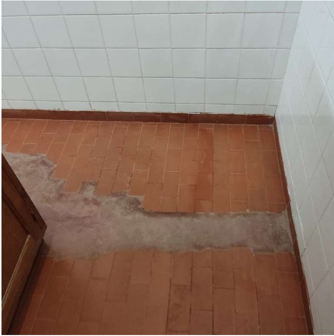
Figura 14 – Piso do vestiário
