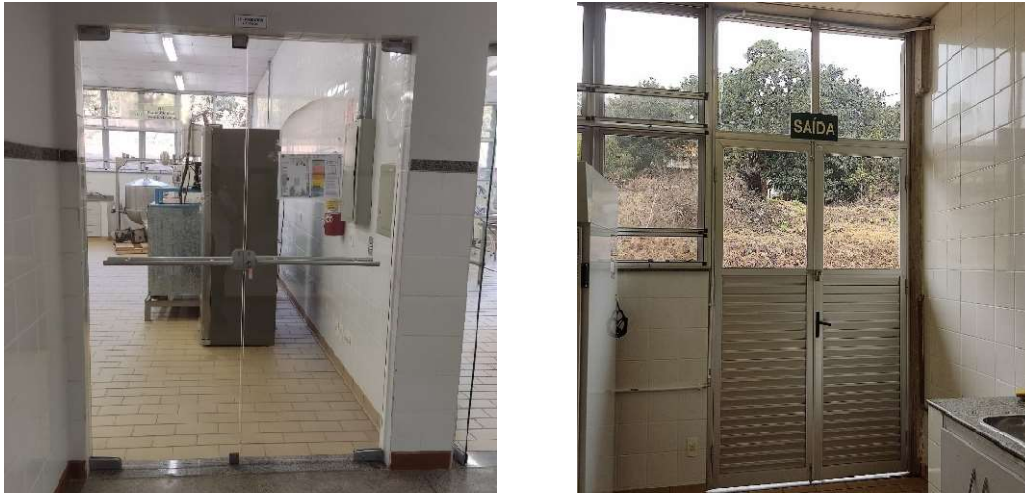
Figura 39 – Porta interna e externa das Planta Piloto
