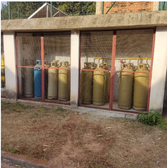
Figura 15 – Cilindros de Distribuição de Gás para as Plantas Piloto.
