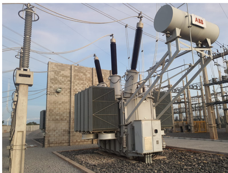
Figura 8 – Transformador de uma usina de distribuição. Fonte: Própria
