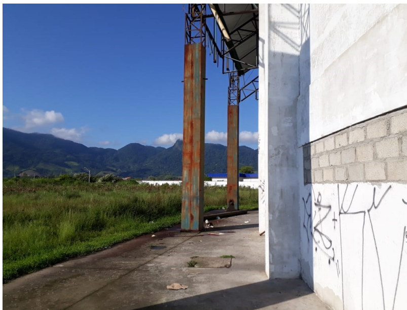
Figura 24: Fechamento dos vãos do ginásio CIDE-Sul com alvenaria
