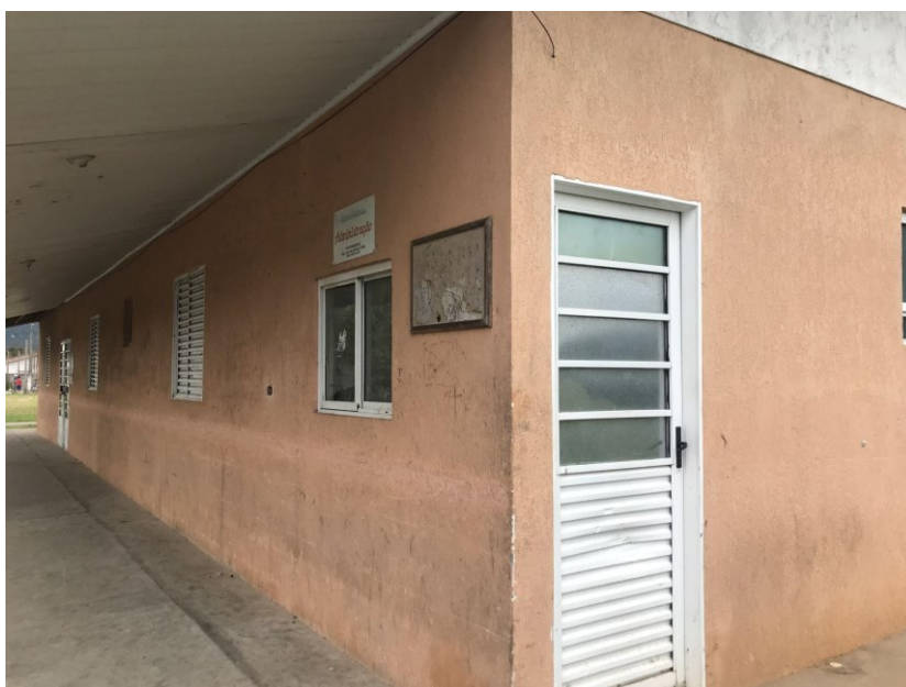
Figura 25: Prédio da administração do condomínio
