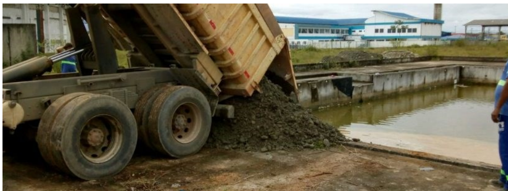
Figura 23: Aterramento de piscina do CIDE-Sul
