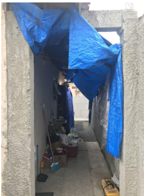
Figura 34: Lavanderia com lona de unidade habitacional no Residencial Nova Caraguá I
