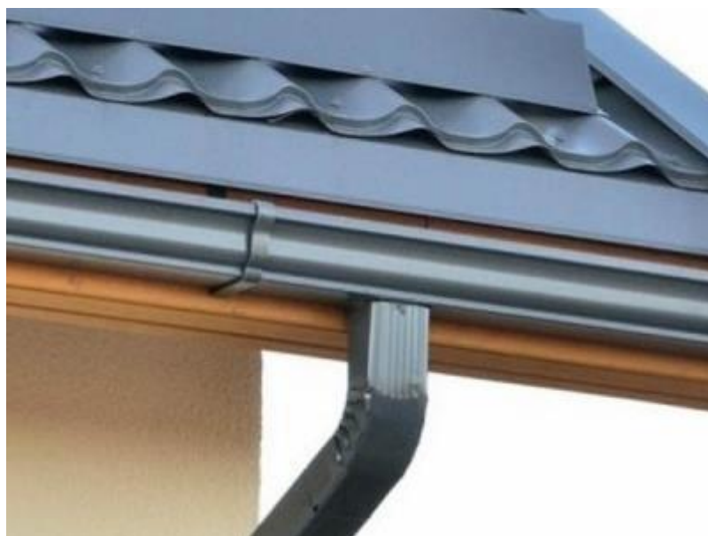
Figura 4 - Calha e Conductor de metal galvanizado
