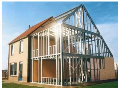
**Fig. 1 - Exemplo de construção em Light Steel Frame.**
