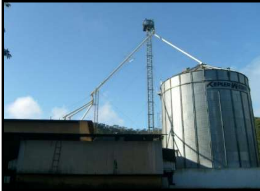
Figura 15: Galpão onde ocorre a fabricação de Ração
