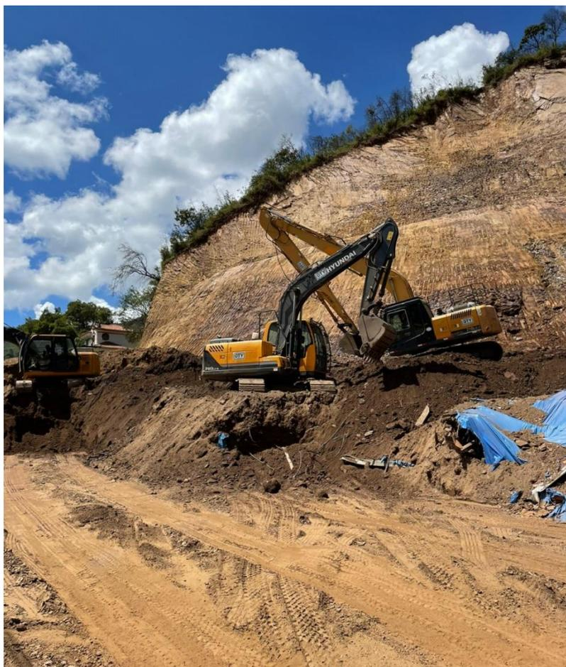
**Figura 12 – Obra de retaludamento no Morro da Forca após a ruptura. Fonte: Foto de Filipe Lage, via Portal Prefeitura de Ouro Preto.**
