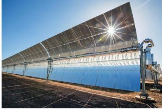
Figura 10: Coletores solares parabólicos.
