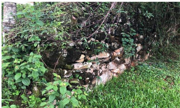
Figura 4 - Ruínas do Muro do Colégio Osório - Foto: Larissa Gonçalves
