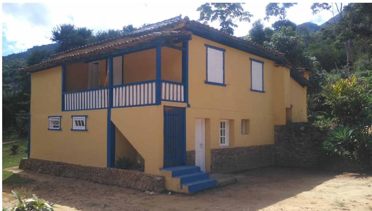
Figura 8- Pousada Serra D'água, localizado no Município de Araponga
