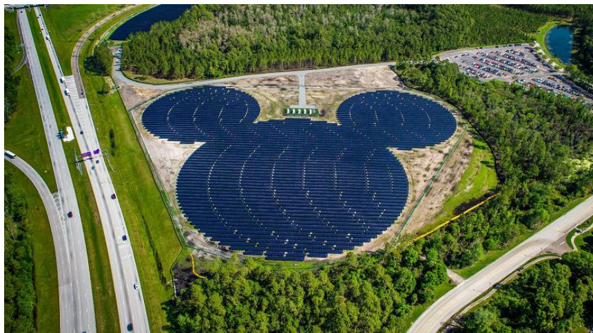
Figura 1 – Usina solar fotovoltaica dos parques Disney World, Flórida, Estados Unidos
