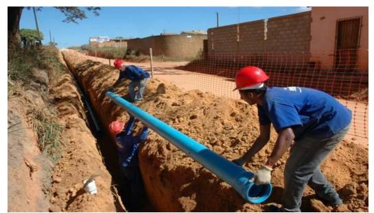
Figura 7: Assentamento da tubulação da rede de distribuição de água Fonte: http://eunapolis.ba.gov.br/?p=1864
