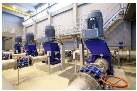
Figura 3: Estação elevatória de água bruta Fonte: http://www.adp.pt/pt//?id=61&img=13&bl=2
