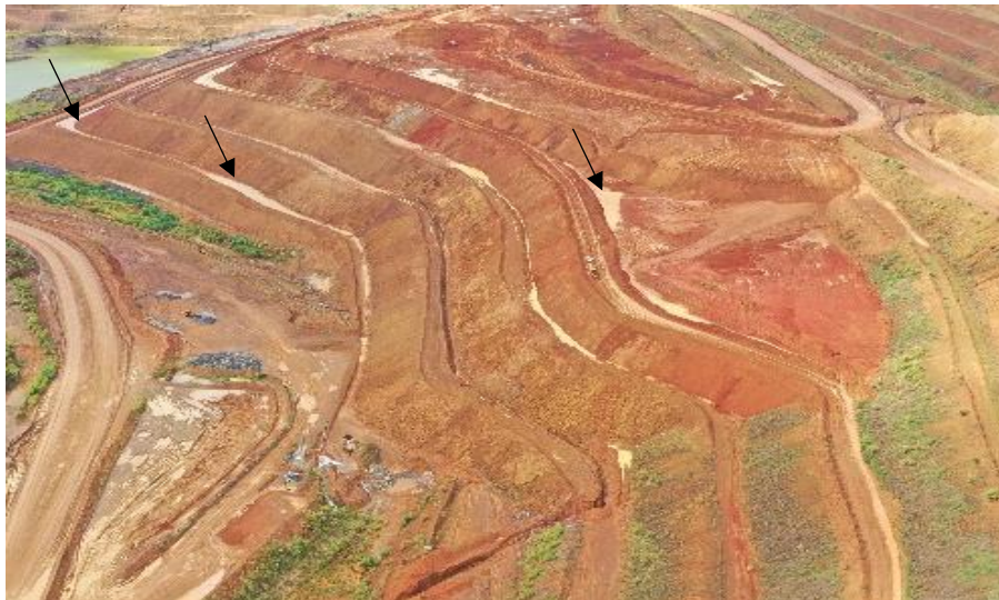
Figura 4.6 – Imagem de drone de uma pilha de estéril no Complexo de Mineração de Tapira destacando o acúmulo de água na superfície da berma (Fotos de drone da Mosaic Fertilizantes 2021).
