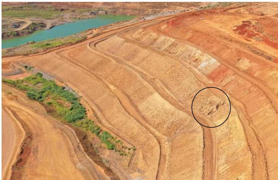
Figura 4.7 – Imagem de drone de uma pilha de estéril no Complexo de Mineração de Tapira destacando o processo erosivo nos taludes (Fotos de drone da Mosaic Fertilizantes 2021).
