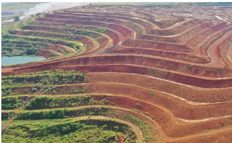
Figura 4.5 – Imagem de drone de uma pilha de estéril no Complexo de Mineração de Tapira destacando a geometria do maciço (Fotos de drone da Mosaic Fertilizantes 2021).
