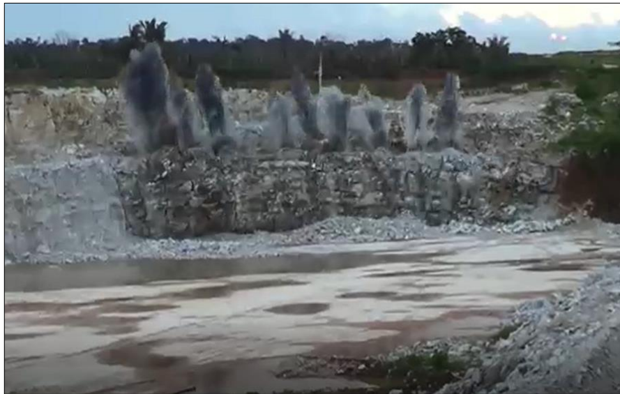
Figura 6: Desmonte de rocha por explosivos. Fonte: Autoria própria
