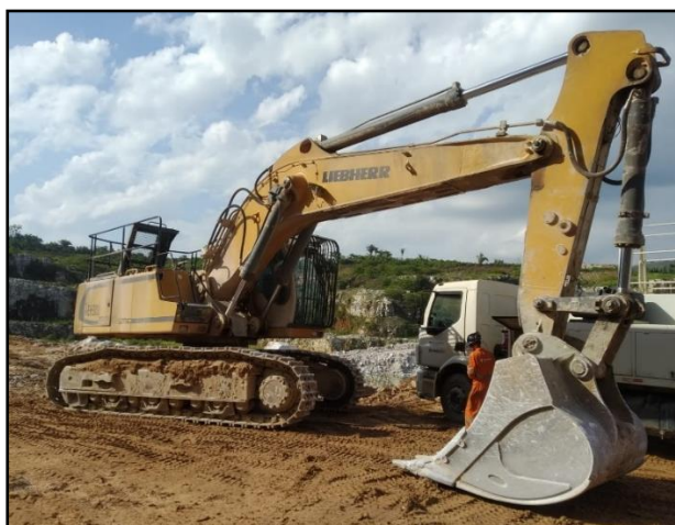
Figura 23: Retroescavadeira Hidráulica LIEBHERR R 954 SME. Fonte: Autoria própria.
