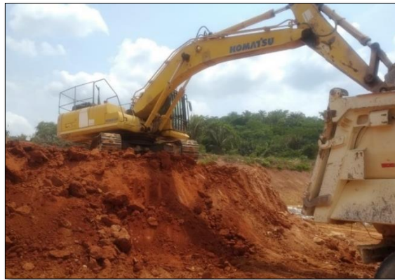
Figura 2: Atividade de decapeamento. Fonte: Autoria Própria
