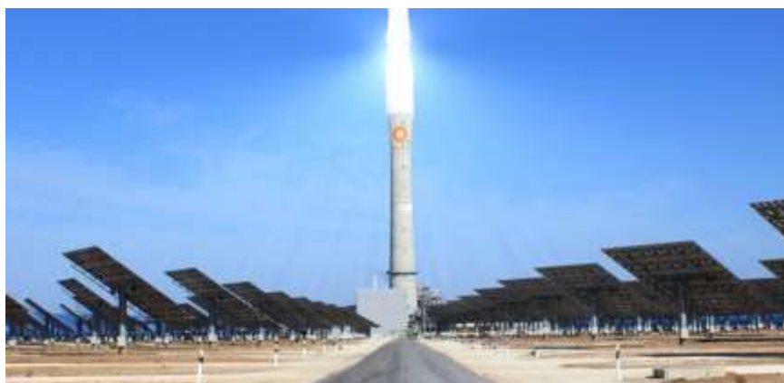
Figura 8: torre solar. Fonte: Solar Volt (2015)
