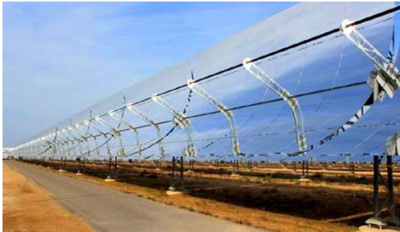
Figura 10: concentrador solar de calha parabólica. Fonte: CCBA (2015)
