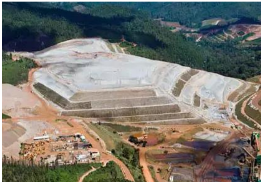
Figura 3 — Exemplo de um empilhamento drenado
