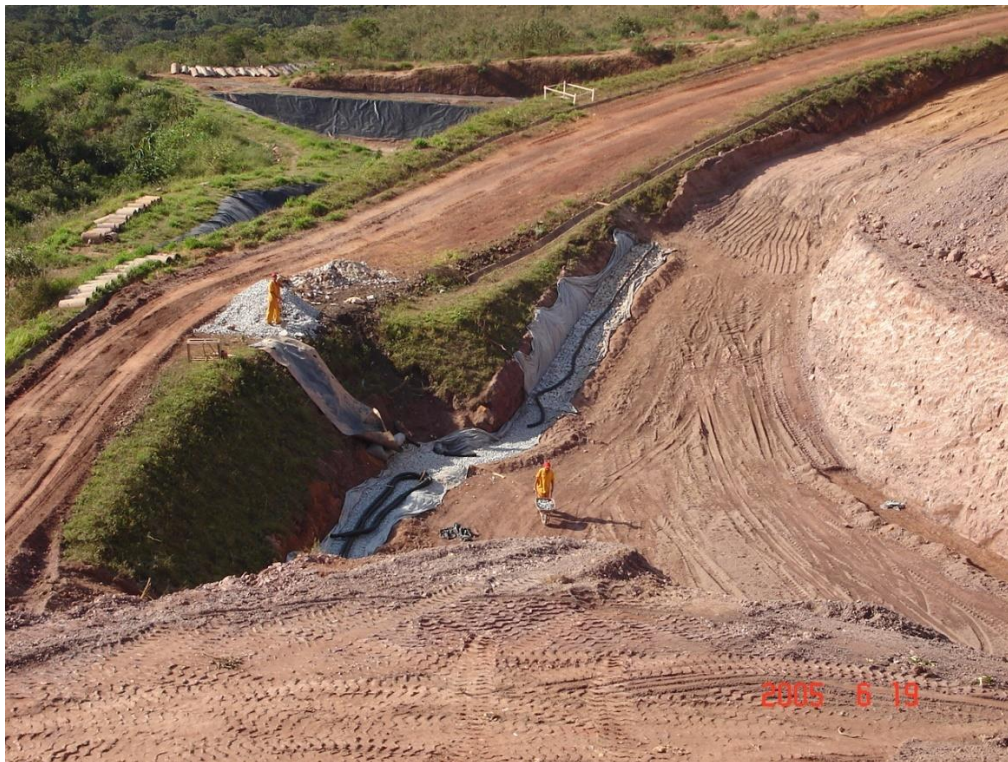
Figura 12 – Imagens a instalação do sistema de drenagem.
